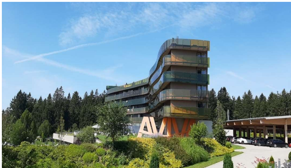
Abbildung 1: Hotel AVIVA-make friends in St. Stefan am Walde. Die geschwungene Form des Gebäudes sowie die dunkelgrün-hellgrün-gelb-orange schillernden Glastafeln der Balkone fügen sich harmonisch in die von Wald und Wiesen geprägte Hügellandschaft ein. (Foto: Fritz Bertlwieser 2024)
